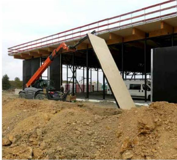
Préfabriqués en atelier (à proximité du site) puis acheminés sur site, les panneaux sont simplement posés contre la charpente
