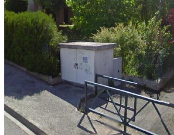
L'alimentation électrique s'effectuera par le biais de l'armoire visible ci-dessus et ainsi permettre un acheminement par le tracé dessiné en rouge sur une longueur de **300 ml** avec une armoire privée de 800 kw à l'arrivée.
