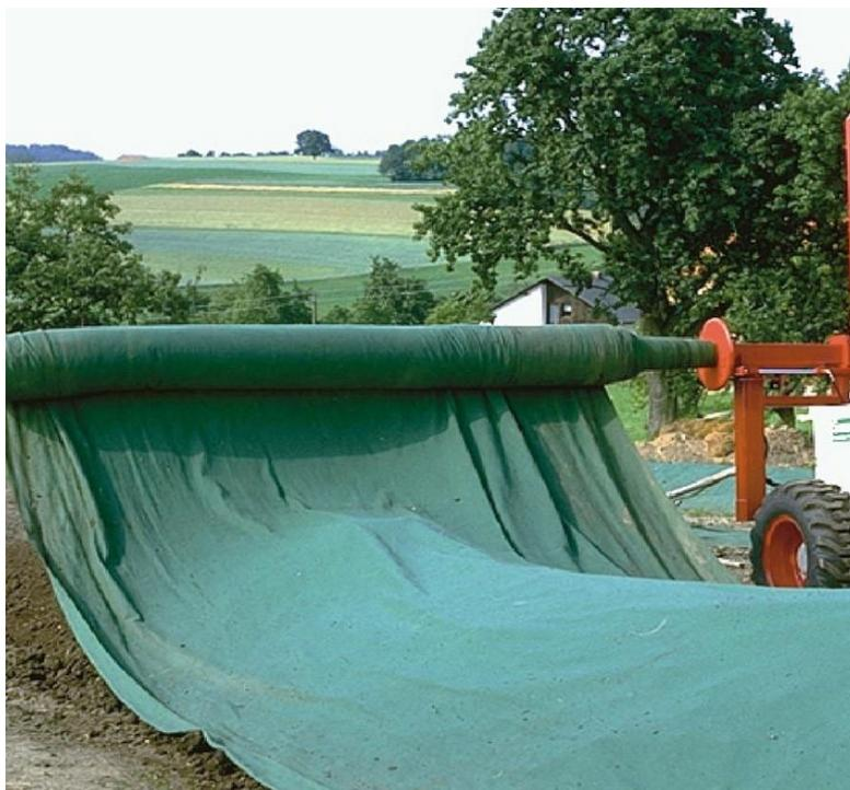
Photographie 4 : Mise en place d'un géo-textile Top-Tex sur un andain après le dernier retournement (Source : [www.baches-gangloff.fr](http://www.baches-gangloff.fr)).
