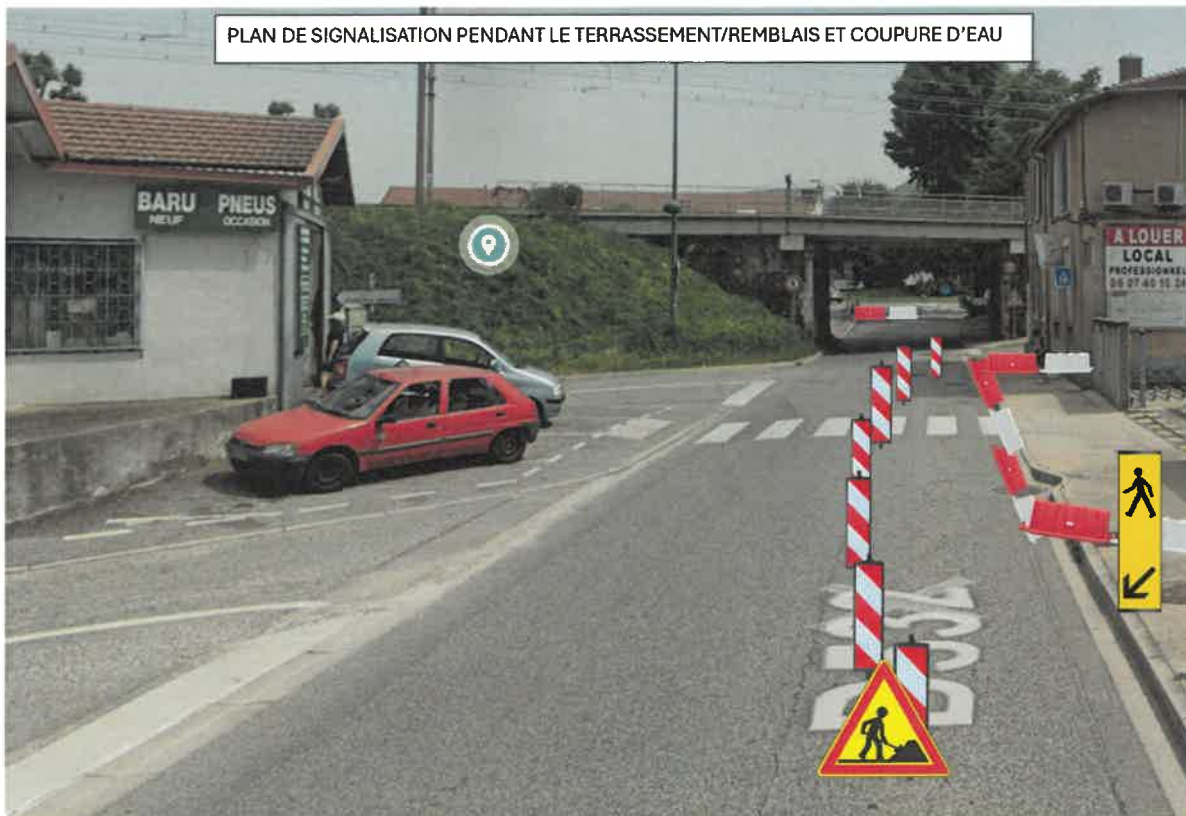
SIGNALISATION 15 ROUTE DE LAMASTRE.
