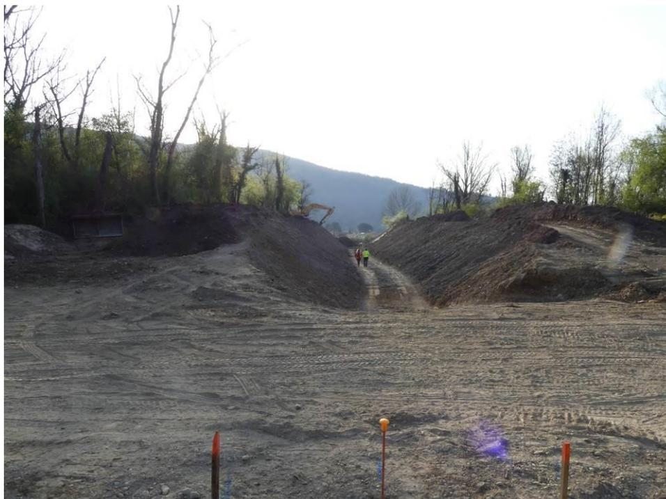
Ouverture du remblai CNR pour permettre l'évacuation des eaux en cas de débordement
