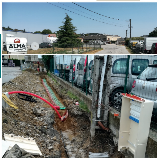
Z.A. la Gare Commune de Saint Donat sur l'Herbasse, enfouissement des réseaux aériens
