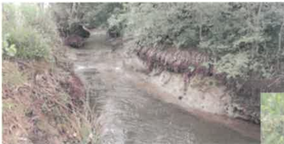
Avant, la Veune coule sur un socle Argileux
