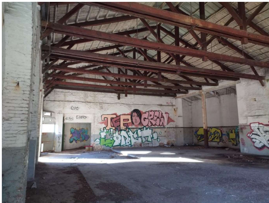
Figure 9 : La Halle Nord conservée, vue depuis l'intérieur
